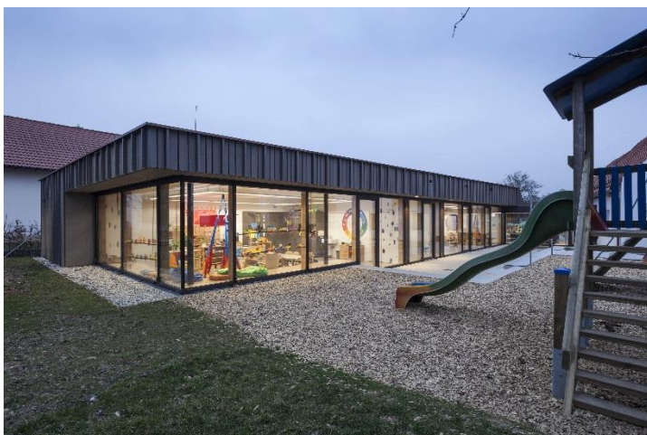
Blick nördliche Seite Kindergartenbereich 1
